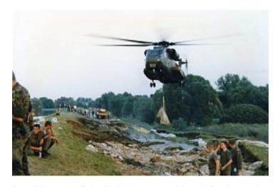
Der Einsatz auf der Deichkrone und im tiefer liegenden Böschungsbereich konnte im Hinblick auf die ausgehende Gefährdung nur schwer eingestuft werden. Um die Standfestigkeit und Stabilität des Damms zu erhöhen, wurde das völlig durchnässte Erdreich mit Sandsäcken beschwert.
