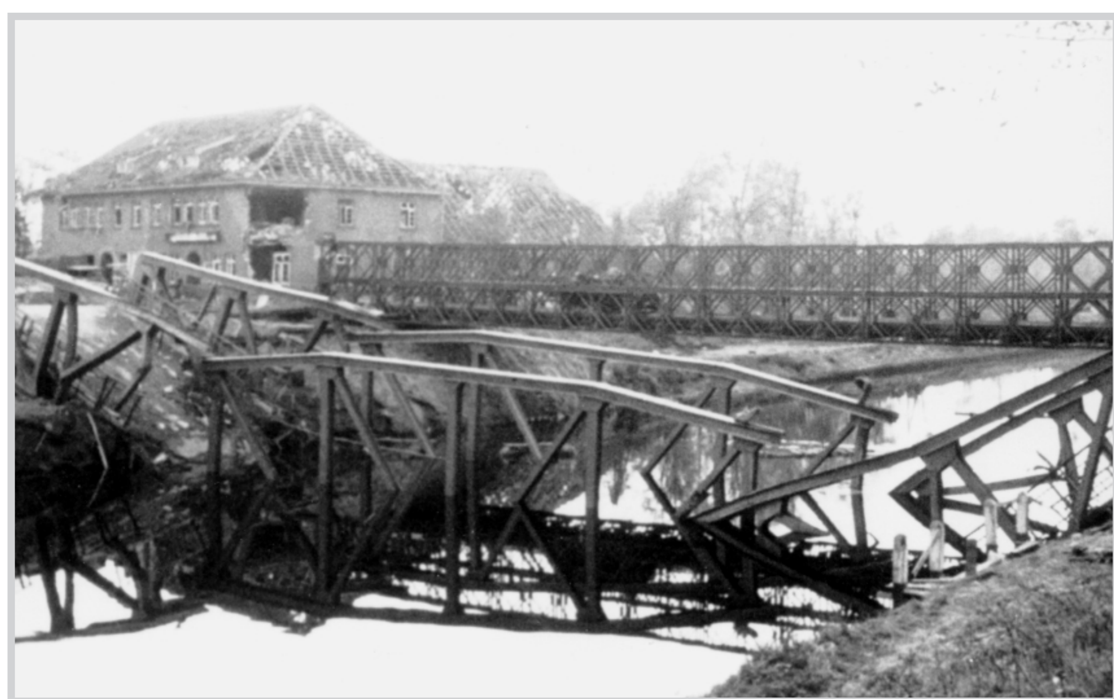
Zerstörte Kanalbrücke in Edewechterdamm. Im Hintergrund die von kanadischen Truppen errichtete Behelfsbrücke (sogen. Bailey-Brücke) und der Gasthof Duhme
