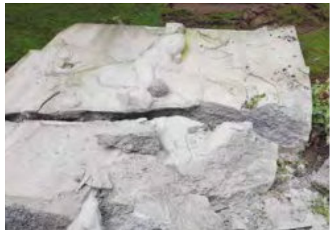
Das zerstörte Relief des Husarendenkmal
